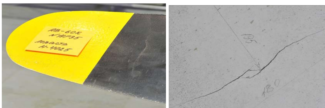
а) Трещина усталости до удаления краски б) Трещина усталости после удаления краски Рис. 1. Трещина усталости
