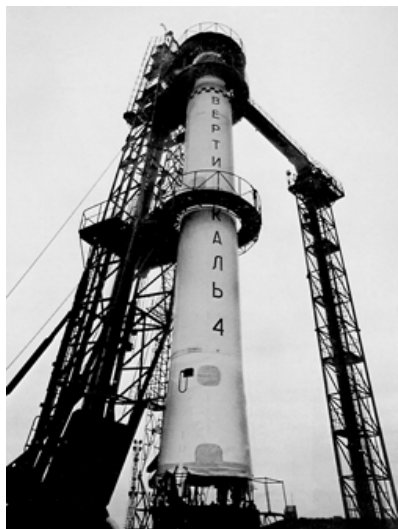
Фиг. 4. а) Геофизичната ракета „Вертикал-4“ с прибор П2Р на старт от космодрума Кап Яр на 14.10.1976 г.; б) Предстартова подготовка на „Вертикал-10“ - Таня Иванова и Евгени Вътев почистват сондата на Ленгмиур на прибор ЗОНД-Р под „зоркото око“ на руския куратор В.Ф.Губский.
